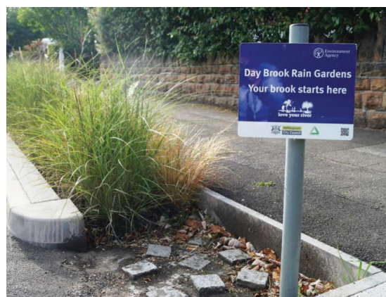
Figura 18 ingresso di acqua dalla strada con elementi in pietra per la dissipazione del flusso
