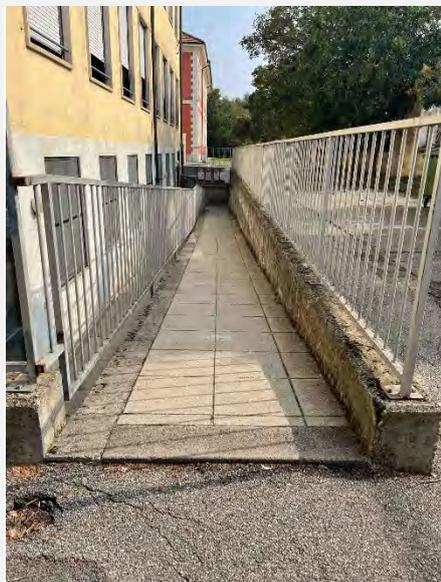
Edificio giallo: uscita emergenza mensa scalino 3 cm a inizio rampa
