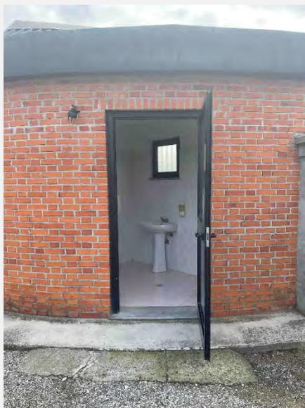
Scalino di 3cm e assenza percorso di raccordo con ingressi
